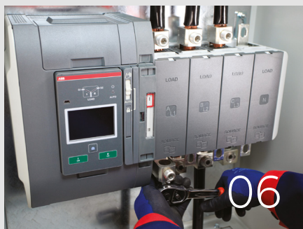
Automatický prepínač pre kritické napájanie
