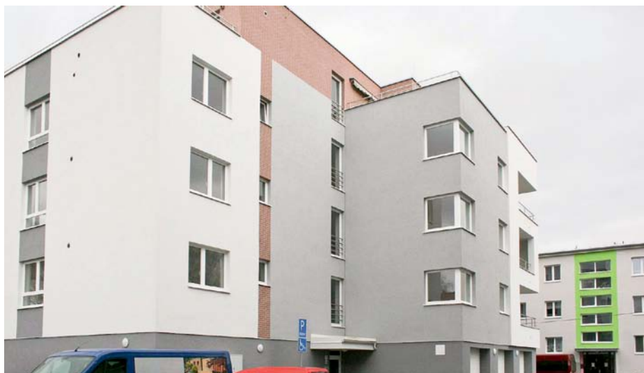
1 a 2 Byty v oboch obytných domoch sú prispôsobované požiadavkám zákazníka aj po stránke elektroinštalácie, pričom dominujú produkty ABB
