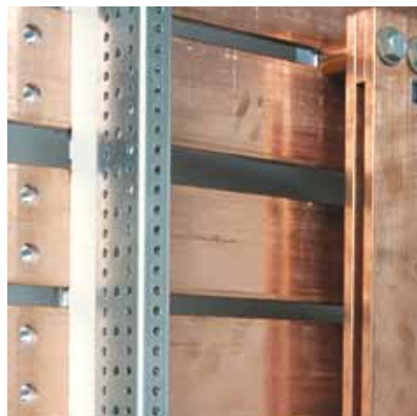
Pozícia hlavných zbernic zvyšuje bezpečnosť osôb a umožňuje zníženie vnútornej teploty.
