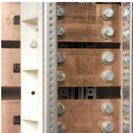
Bezúdržbové zbernicové prepojenia zaručujú optimalizované kontaktovanie a tým vysokú úroveň bezpečnosti, použiteľnosti a hospodárnosti.
